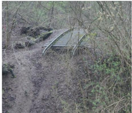
*Teilweise ist das Gleis noch in guten Zustand. Der Dammrutsch macht knapp die Hälfte der Kosten für eine einfache Wiederherstellung der Strecke aus. (Bilder: M. Wiegner).*
